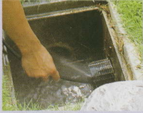
▲排水口の洗浄
