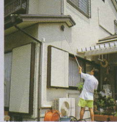
▲建造物のリフォーム
