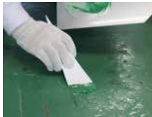
ゴムベラやパテベラ等で欠損部に塗り込んで修正します。
