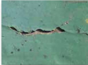
下地のゴミやホコリ・浮き塗膜など取り除き、十分に乾燥させます。
