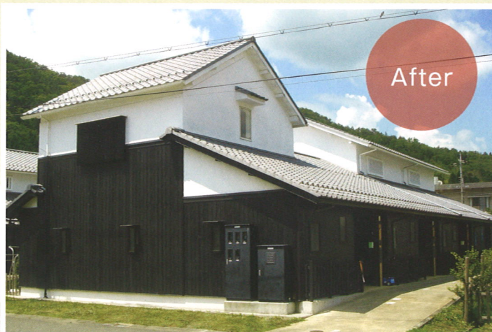
兵庫県篠山市 福住本陣団地(重要伝統的建造物群保存地区) キシラデコール アクオステージ #412 ジェットブラック
