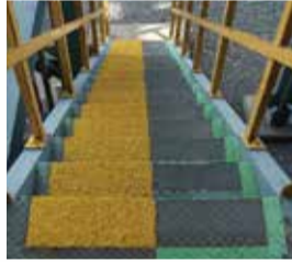
封鎖できない階段の塗り方 (塗る日を変えて半分ずつ塗布)
