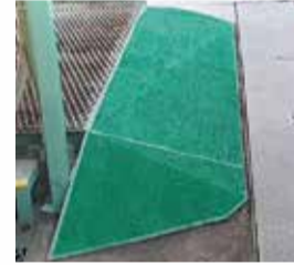
鋼鋼板のスロープ
