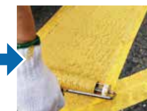
専用のローラーを用いて塗布面にパターン(凸凹)付けし、仕上げます。
