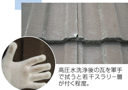
高圧水洗浄後の状態
