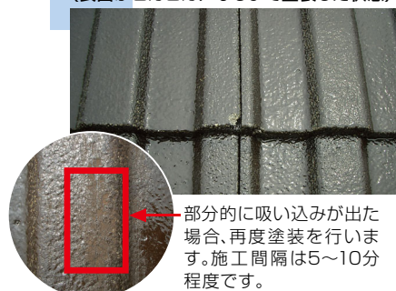
NTスラリー瓦用シーラーを施工 (表面がピカピカになるまで塗装した状態)
