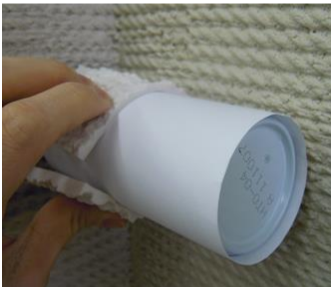
写真1 入れ隅シートの使用例（写真はJR-182Sを使用しています）
