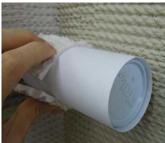
写真 入隅シートの使用例 < 施工の注意事項 >
