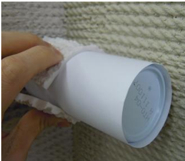
写真1 入隅シートの使用例 (写真はJR-182Sを使用しています)
