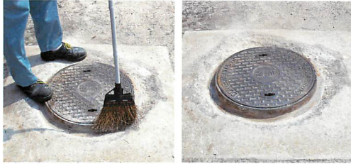
被塗面のゴミ・ホコリを除去 素地調整完了
