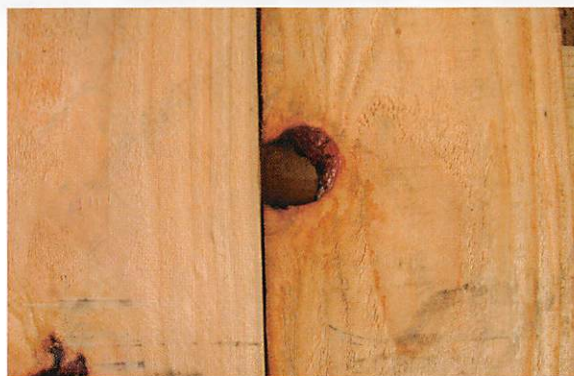
フシ抜け補修
