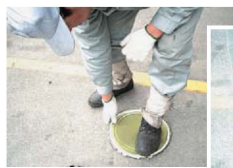
④蓋の縁でポリ袋が破れるのを防ぐため、蓋を折り曲げてください。
