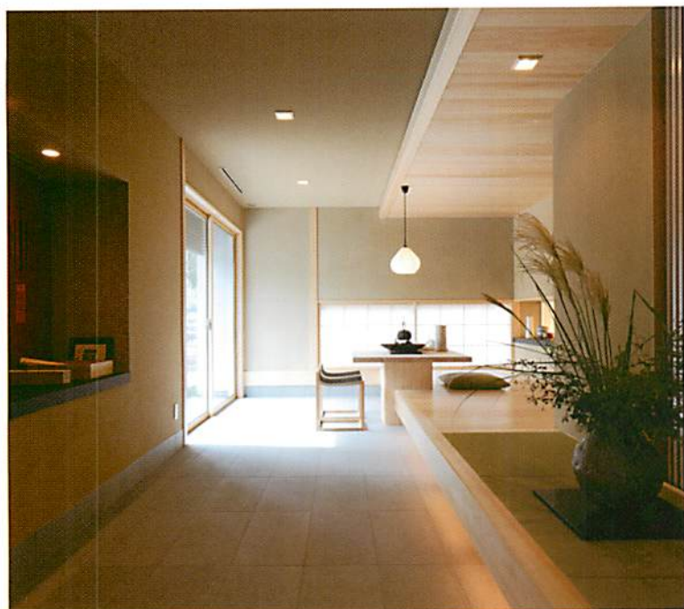
ミサワホーム東京株式会社新宿展示場 仕上げ: (壁) 撫切り仕上げ、(天井) 敷き仕上げ
