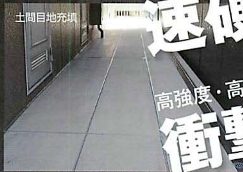
工場や倉庫のコンクリート床のひび割れ補修
