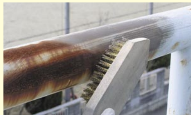
2. 下地調整 下地の種類やさびの発生程度によって 適正なケレン作業を行う
