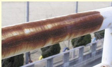
1. 下地確認 さびの発生状況の確認
