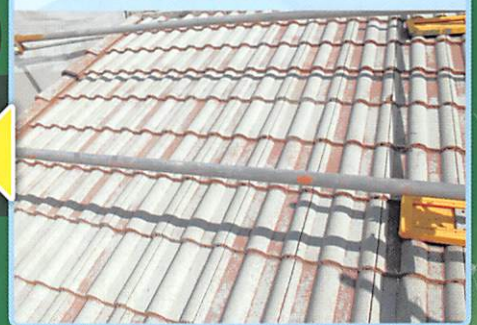
高圧水洗浄後
