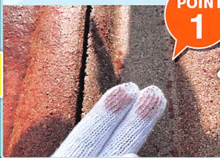
高圧水洗浄後 (接写)
