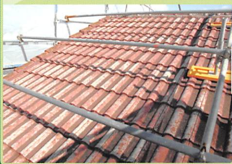
施工前 (高圧水洗浄前)
