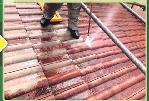
高圧水洗浄工程
