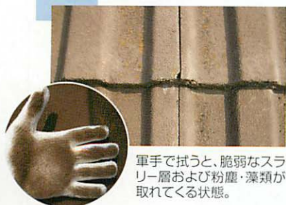
スラリー瓦洗浄前の状態
