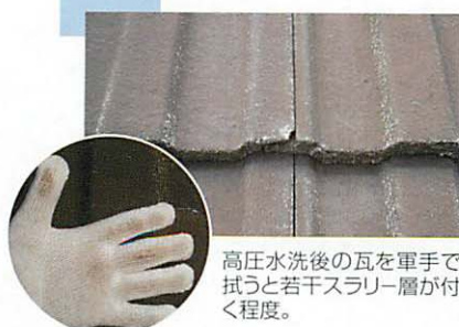
高圧水洗後の状態
