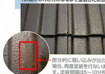
NTスラリー瓦用シーラーを施工 (表面がピカピカになるまで塗装した状態)
