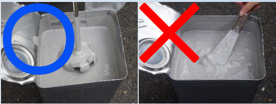
開封時：表面が乾燥 ①ヘラで容器と塗料を ②固形分に切り込みを ③機械で攪拌する。 切り分ける。 入れる。
