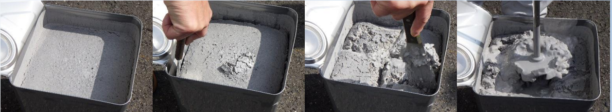
開封時：表面が乾燥 ①ヘラで容器と塗料を ②固形分に切り込みを ③機械で攪拌する。 切り分ける。 入れる。
