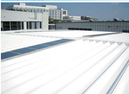
▲鋼板屋根にサーモアイSiクールホワイトを塗装
