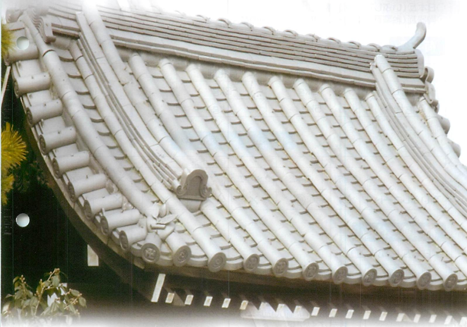
業界唯一のいぶし瓦塗り替え専用塗料として好評を博した「いぶしコート」が、さらなる進化を遂げました。従来のいぶし瓦に加えて陶器瓦の塗り替えもできるようになり、業界初の粘土瓦塗り替え専用塗料にグレードアップして、装いを新たにお届けします。
