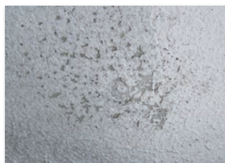
塗膜の剥がれ
