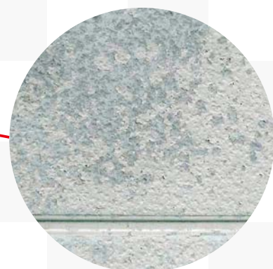
塗膜の剥がれ・割れ
