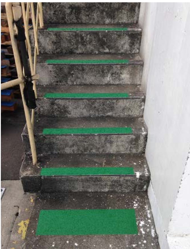
[写真-7] 塗工完了
