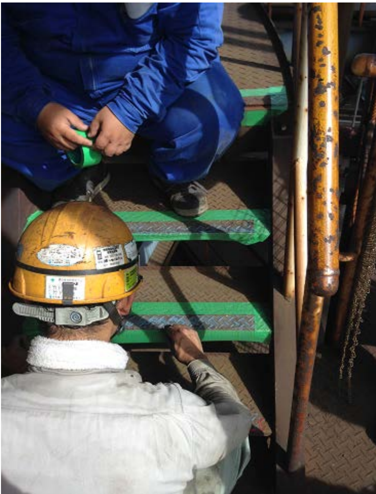
[写真-4] 脱脂洗浄後、マスクング。
