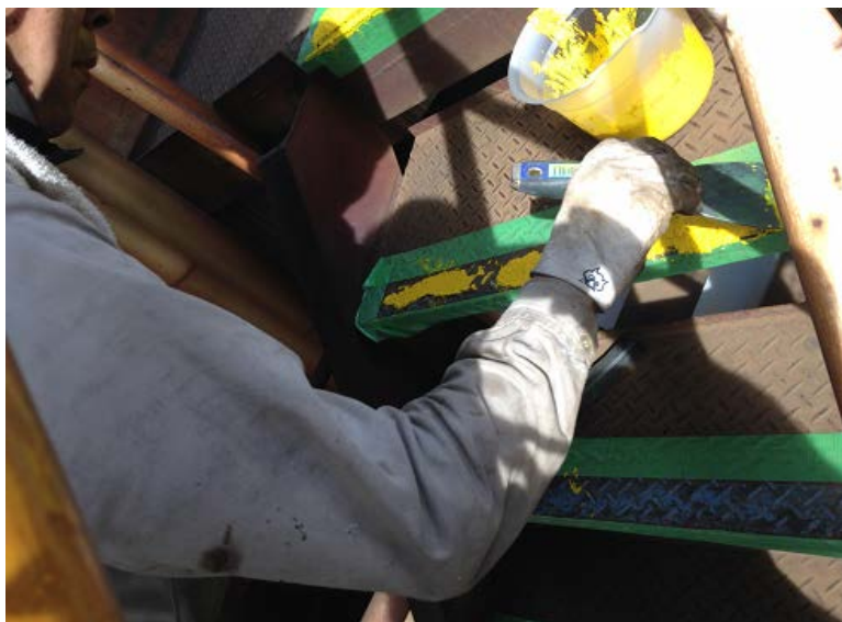
[写真-5] すべり止めコートを金ベラで塗り広げてから、 短毛ローラーにて凹凸を付ける。
