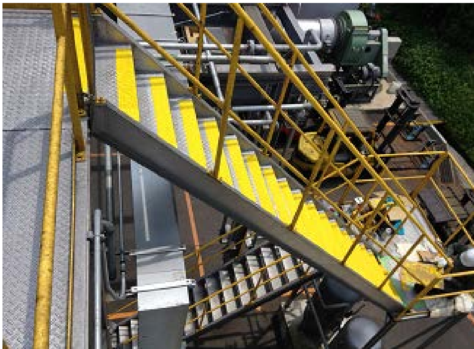
[写真-7] 短毛ローラーを使うことで 縞鋼板への塗布も、 均一に薄く塗布することが 可能となる。
