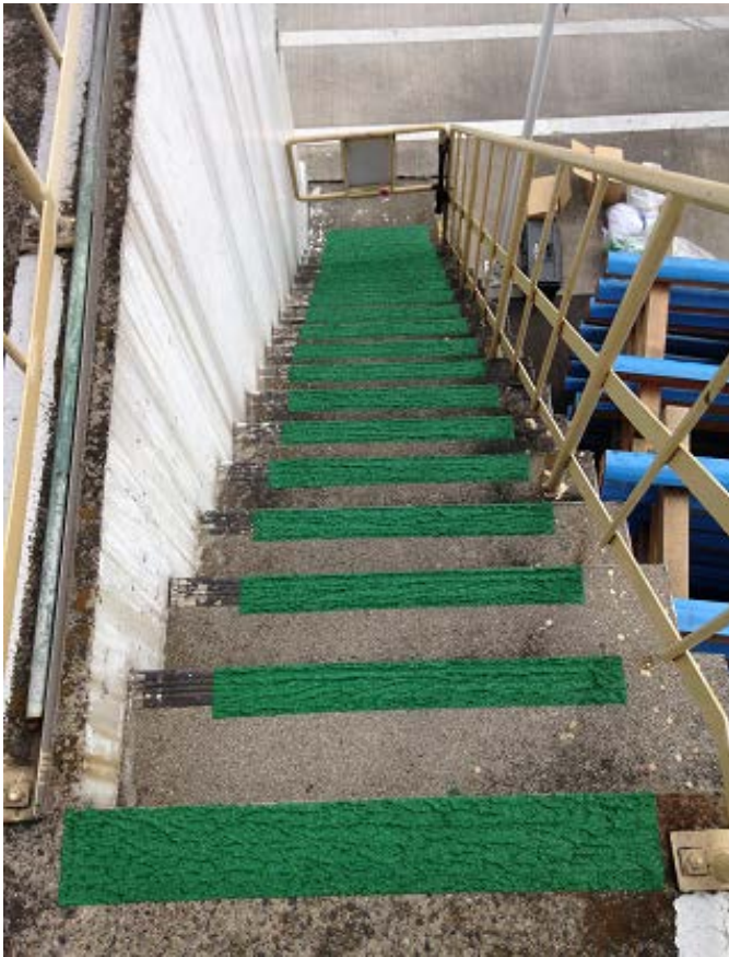
[写真-6] 塗工完了
