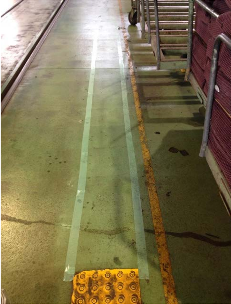
[写真-3] マスキング処理。
