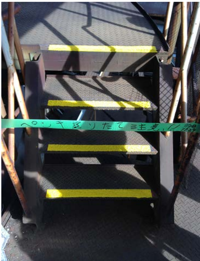
[写真-6] 塗工完了
