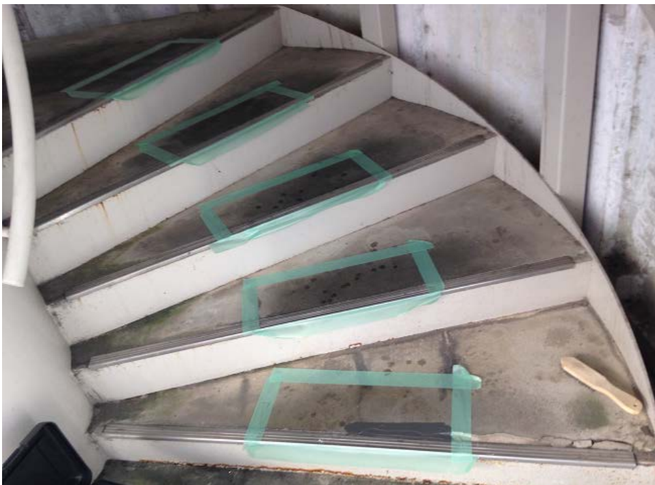
[写真-5] マスキング処理。 養生テープにてマスキング。
