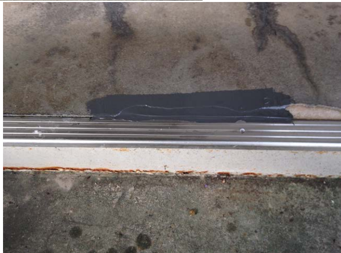
[写真-4] 超速鉄メタル。 施工後。
