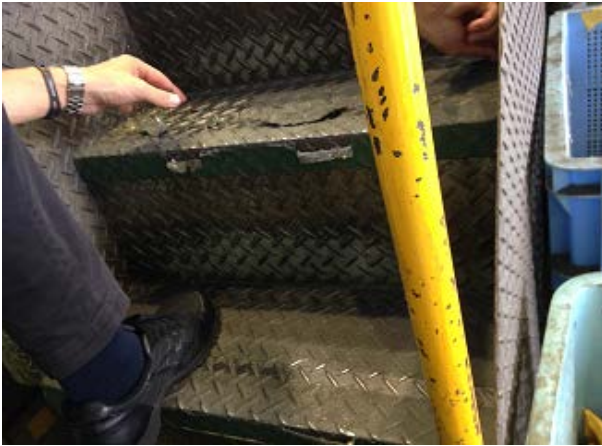
[写真-1] 施工前のスロープ。
