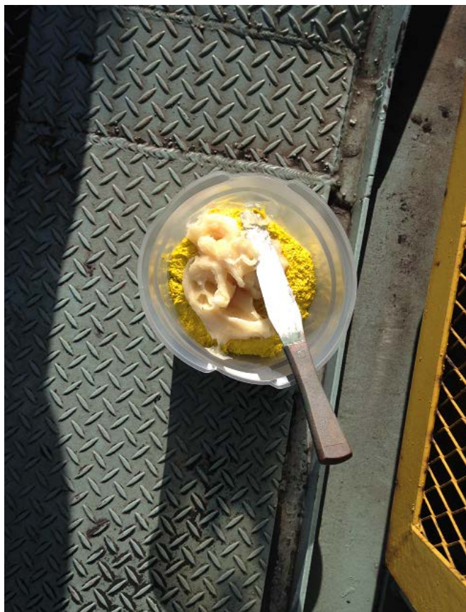
[写真-4] 小分けして必要な量の すべり止めコートの主剤、硬化剤 を計量し、約2分程度念入りに 混合攪拌を行う。
