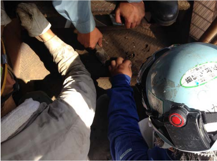
[写真-3] 脱脂洗浄後、マスクング。
