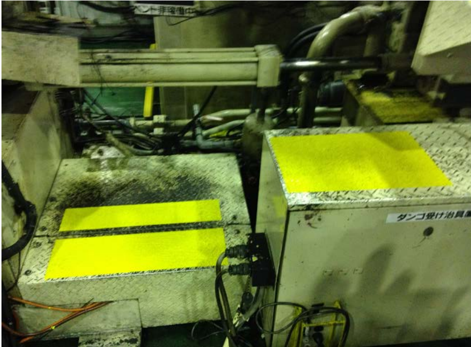
[写真-8] 塗布終了後、直ちにマスクング を除去して、硬化養生。
