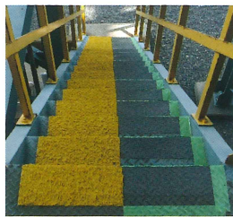
封鎖できない階段の塗り方
