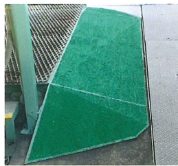
鋼鋼板のスロープ
