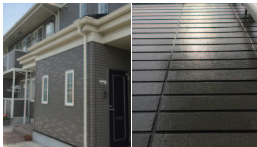
施工後6年経過物件
