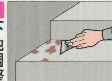
塗る面の砂、油分等の汚れを清掃し、古い塗膜は皮スキ、ワイヤーブラシ等で取り除いて下さい。ビビ割れ、穴はコーキング材、セメント等で埋めて下さい。
